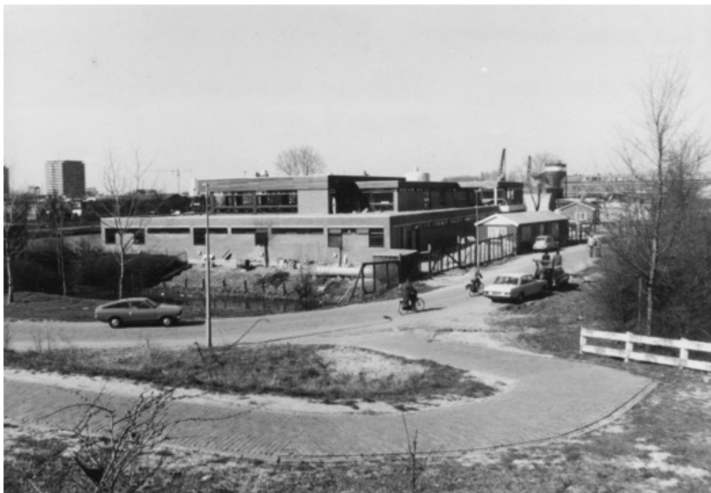
De loods in de afbouwfase, 05-04-1978
