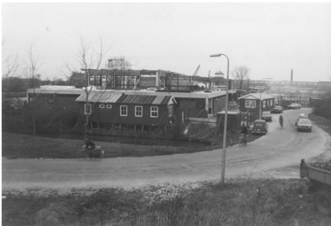
Het bouwterrein aan de Verlengde Hooggravenseweg gezien vanaf het fietspad naar de A12 brug
