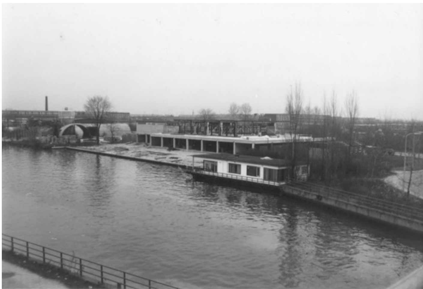
Bouw gezien vanaf de A12 brug op 01-12-1977
