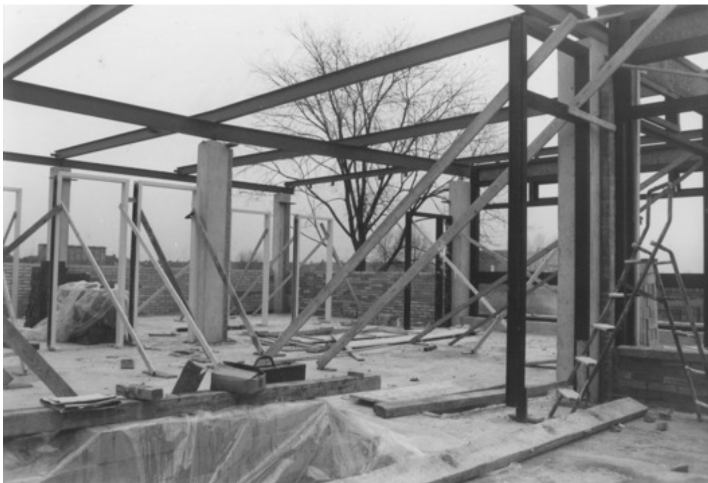
Het stalen skelet van de verdieping met de eerste gestelde vurenhouten kozijnen (foutje in het bestek)
