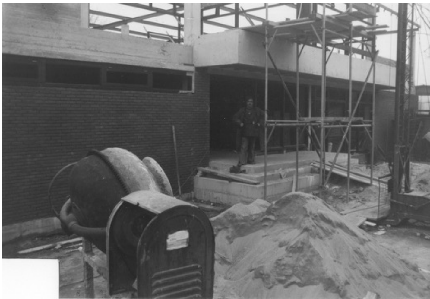
De ingang met metselwerk en het staalskelet voor de opbouw van de verdieping, 01-12-1977
