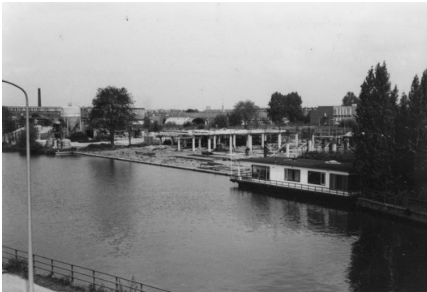
Het betonwerk van de onderbouw, 20-08-1977
