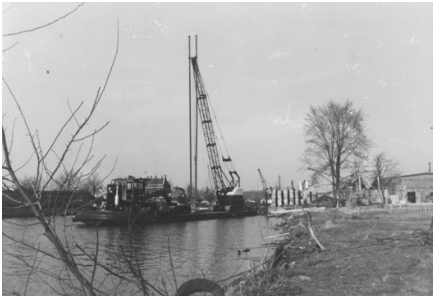
De heistelling voor het slaan van de beschoeiing
