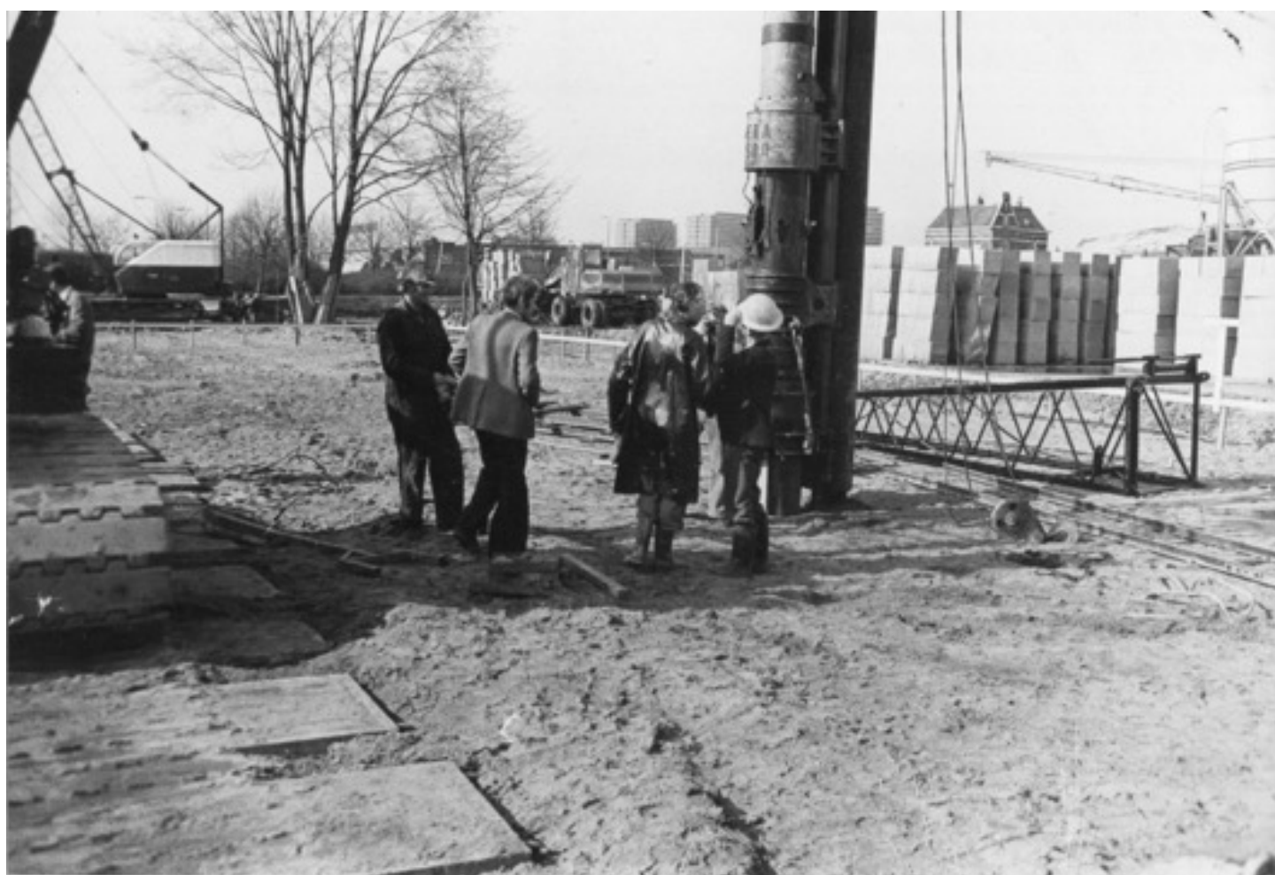
Heien van de eerste paal aan de Verlengde Hooggravense weg op 16-03-1977
