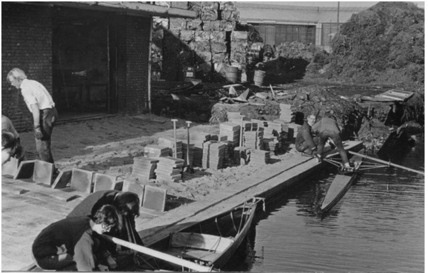
Steigeractie; Tijdens het tegelen gaat het roeien gewoon door.
