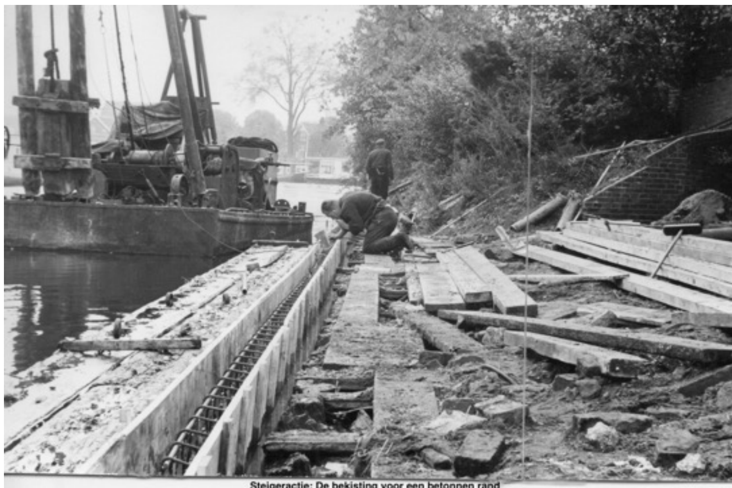
Steigeractie; De bekisting voor een betonnen rand
