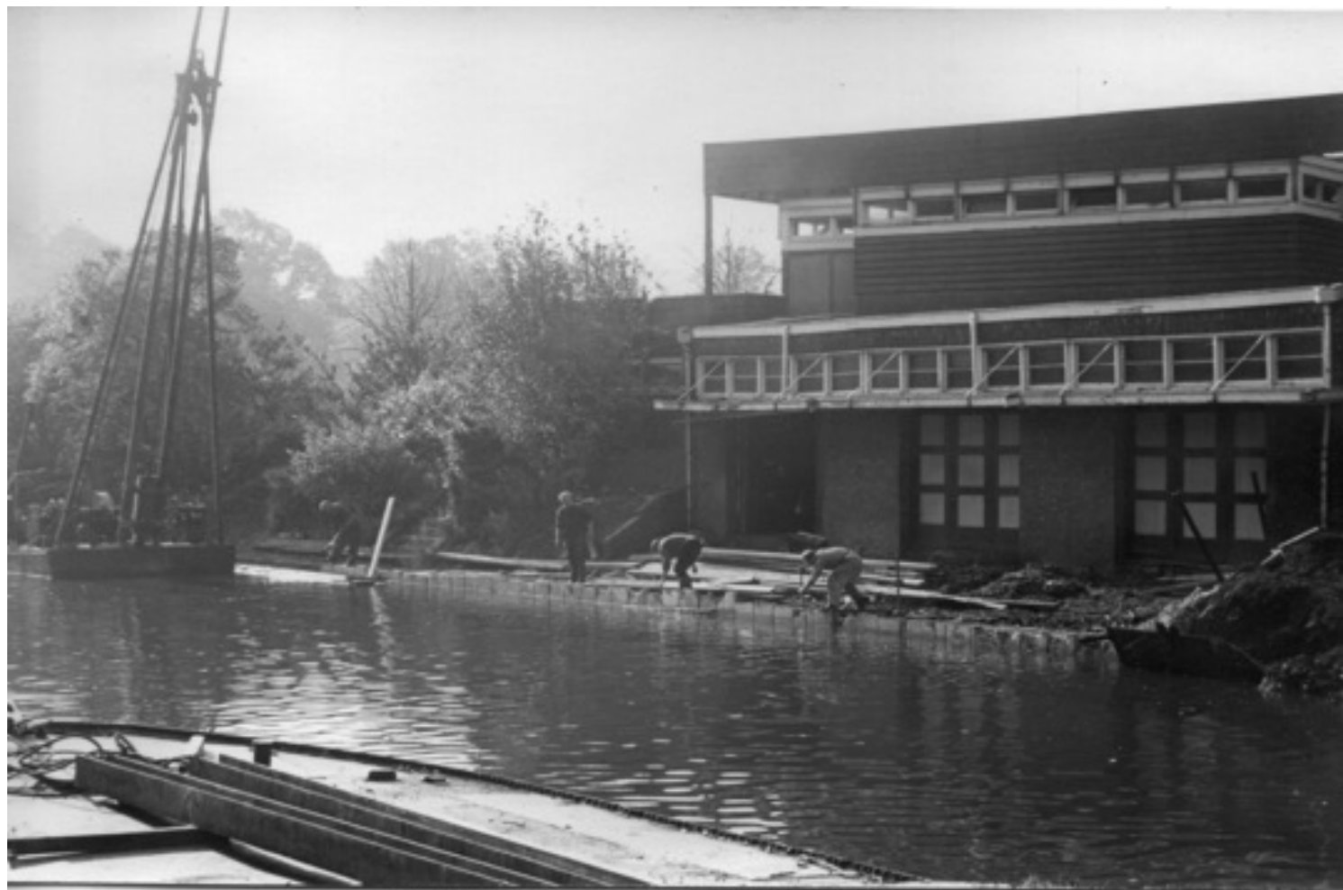
Steigeractie; Nieuwe betonnen platen worden aangebracht.
