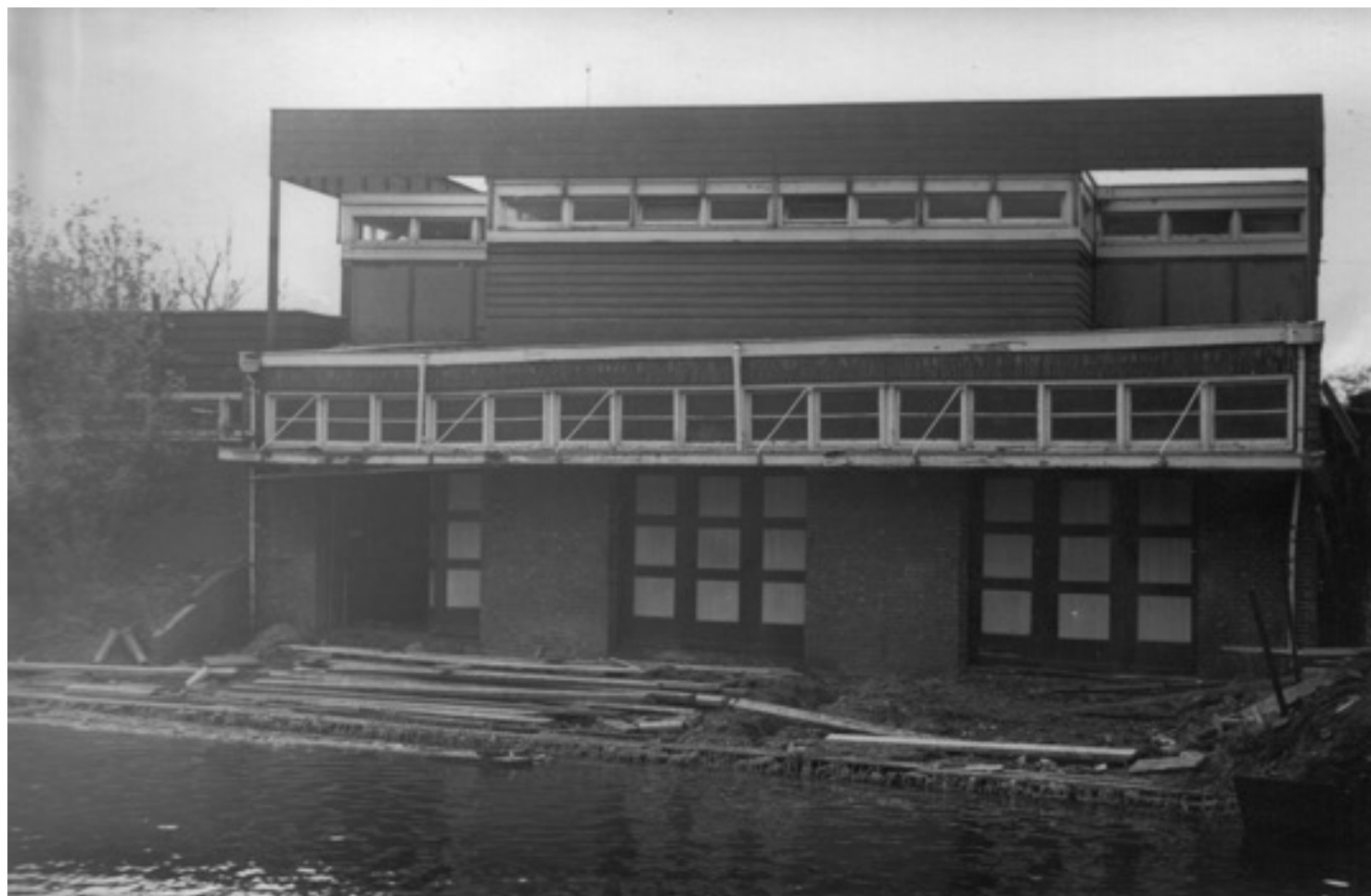
Steigeractie; het plankier en de oude beschoeiing verwijderd. Oktober 1967. Ook het gebouw kan wel wat onderhoud gebruiken.
