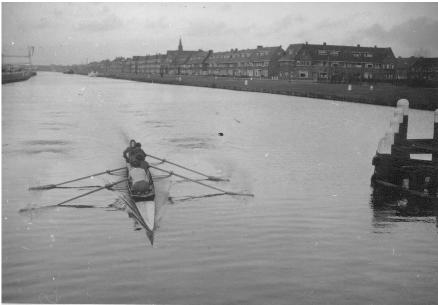
Overnaadse vier "Balder" nadert de Liesbosch draaibrug 1952-1957. Links de kraanbaan met loswal van de HAKA. Voor het huizenblok rechts zou in 1963 de Socrateslaan en de Socratesbrug gebouwd worden
