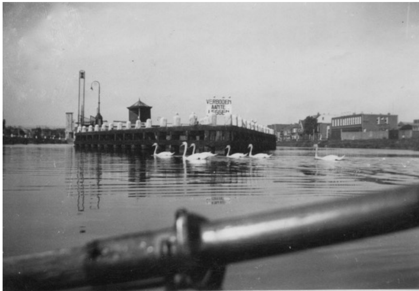
Zomer 1940: Het sluishoofd in het Merwedekanaal bij de Munt
