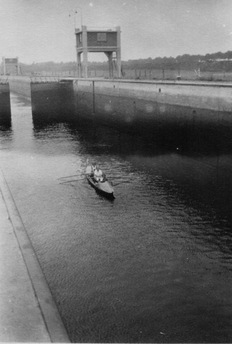
Sluis bij de stuw in de Maas bij Sambeek
