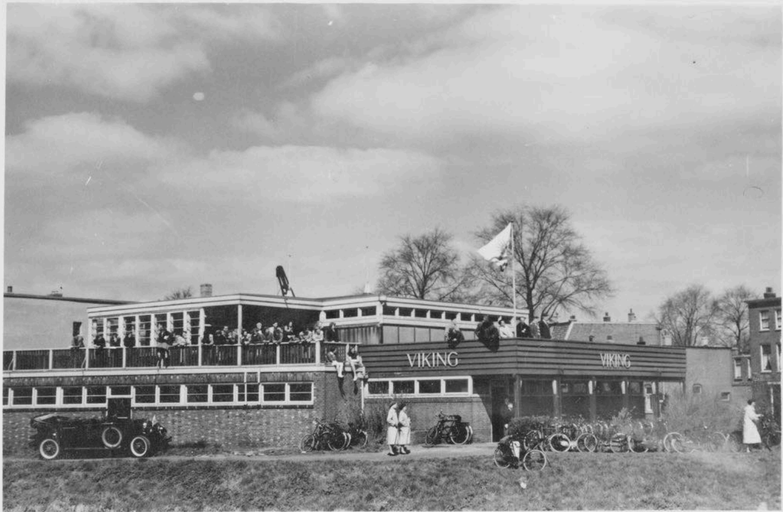
De in 1921 gebouwde nieuwe botenloods van Viking. Tot 1924 stond de eerste loods er aan de rechterzijde waar de fietsen staan nog voor en werd een tijdje door de wedstrijdroeiers van Triton gebruikt totdat de Gorkumse Roeivereniging deze loods kocht.
