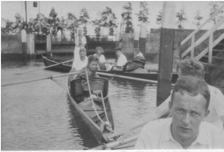
Op weg naar Loosdrecht in de sluis tussen het Merwedekanaal en de Vecht bij Maarssen
