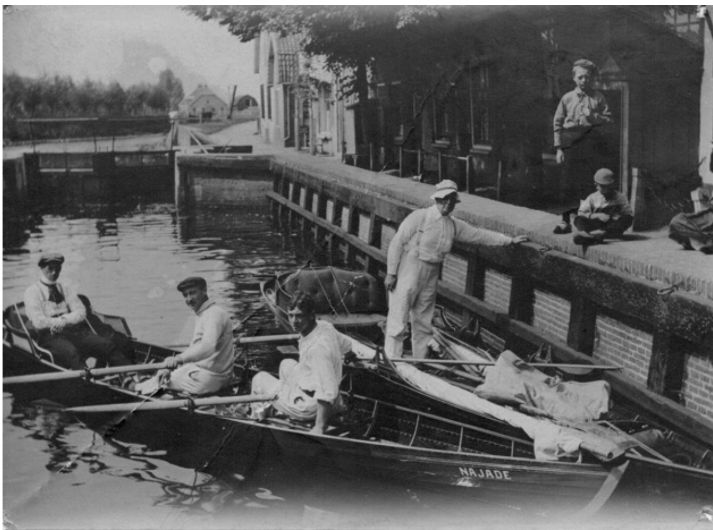
Juli 1913, sluis in de Nieuwe Wetering te Nieuwersluis
